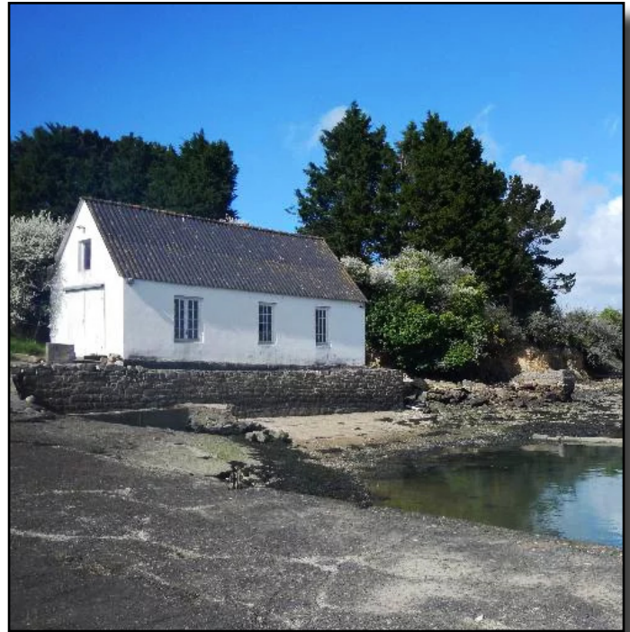
Chantier Ostréicole, Kérivaud, Locmaraquier, © PNRGM
