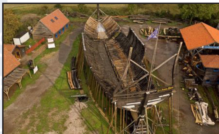
Vue aérienne du chantier du "Jean Bart"
