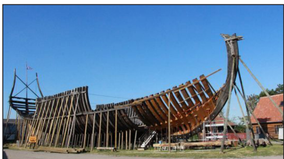
La silhouette du "Jean Bart" sur le chantier
